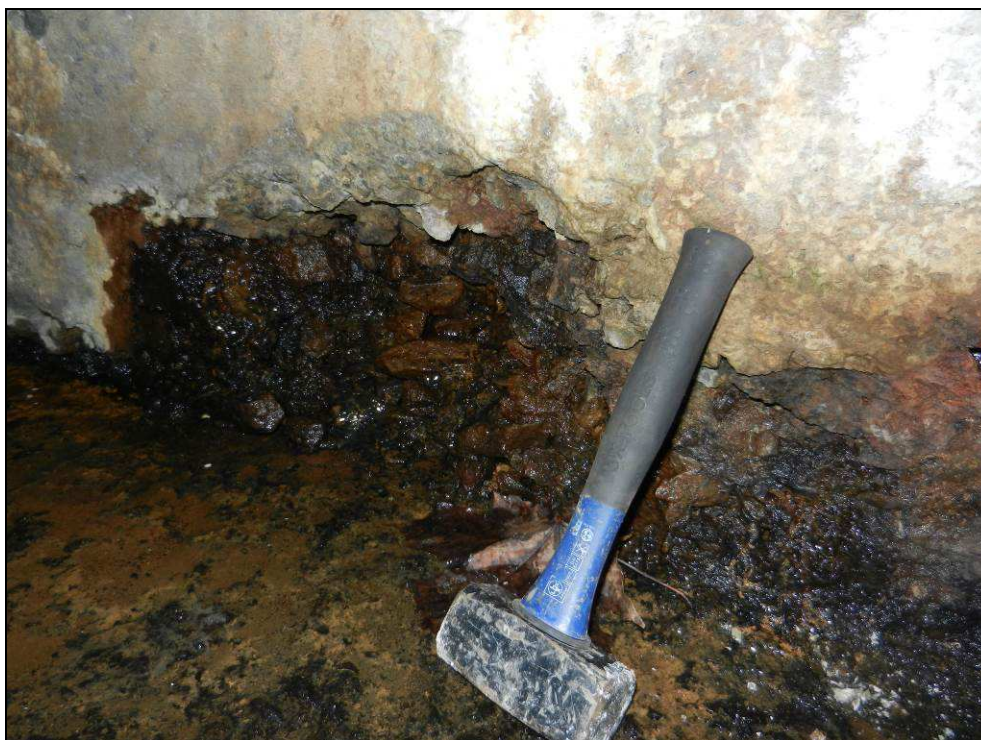
Obr. č. 8 - detailní pohled na rozsáhlé opady betonu při styku SS se dnem propustku v pravé části objektu.
