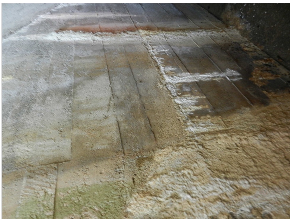
Obr. č. 7 - detailní pohled na průsaky vody lícem SS v pravé části objektu.
